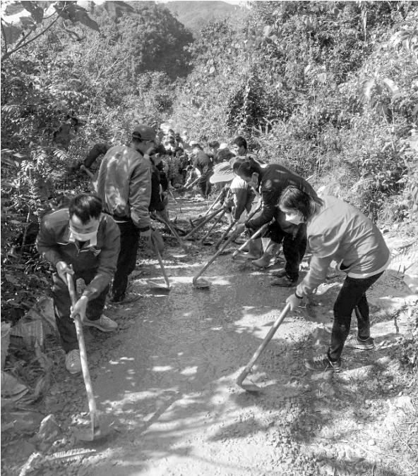
Ra quân làm đường bê tông nông thôn tại xóm Lũng Ót, xã Yên Lạc với chiều dài 300m.
