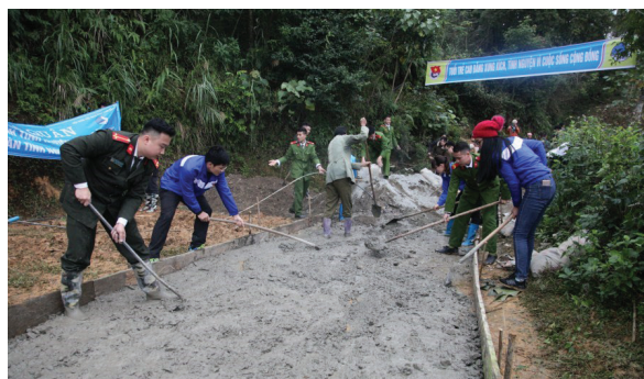
ĐVTN tham gia làm đường bê tông nông thôn tại xóm Nà Hoàng, xã Tam Kim, huyện Nguyên Bình
